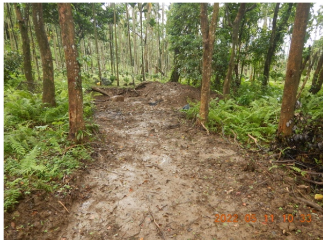
圖 11：滲透井及施工道路
