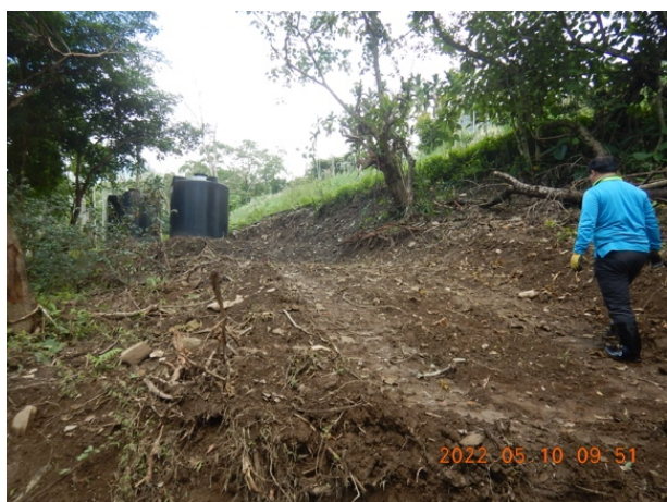
圖 12：建築基地通往水塔施工道路
