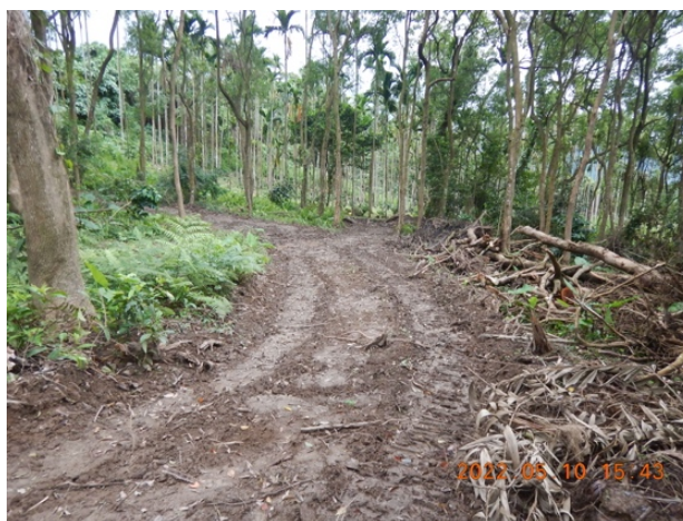
圖 10：建築基地通往滲透井施工道路
