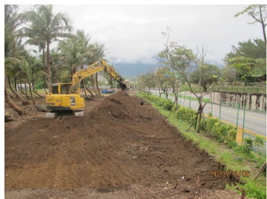
圖 30：施工過程（由南向北拍攝）
