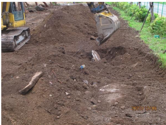
圖 29：清除回填建築廢棄物的深穴
