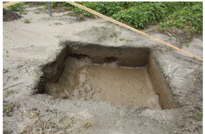
圖 88：TP2 界牆局部崩落
