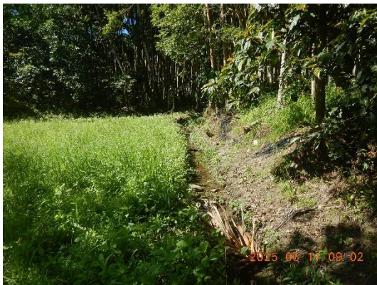
圖 74：東北側下階地的水溝 (GPS 標號 538)
