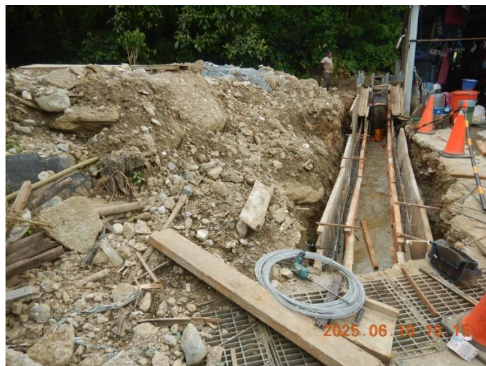
圖 103：重光聚落水溝工程現況
