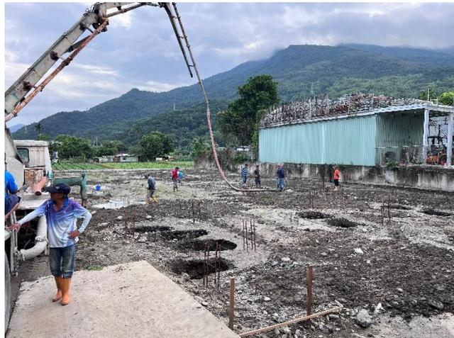
圖 207：施工挖掘與灌漿
